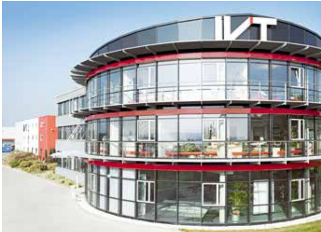
IVT Zentrale, Rohr
