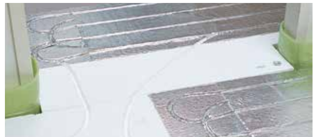
Türrdurchgang mit PRINETO Ausgleichselement.
