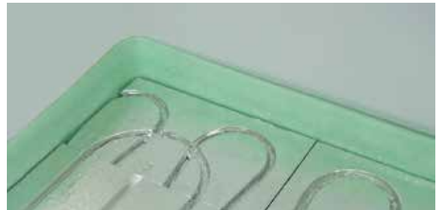
Beginn der Verlegung in einer Raumecke mit PRINETO Wendeelement.
