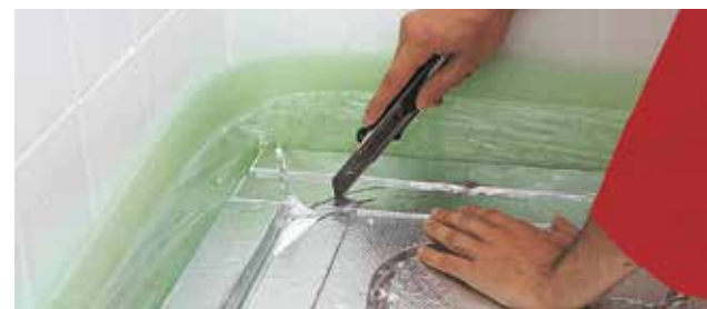
Verbindung der PRINETO Nutenelemente über Eck.
