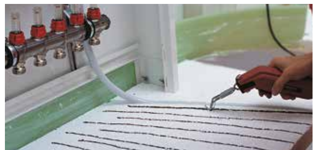
PRINETO Heißschneidewerkzeug zum Vorbereiten individueller Rohrführungen.
