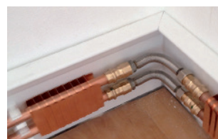
Eckausführung mit Umlenk-Kompensator
