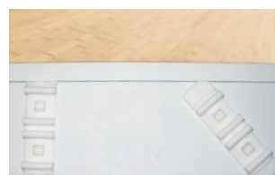
Fixierung Kunststoffhalter an der Blende
