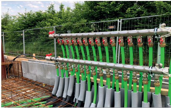
ÖKO-FLEX Heizkreisverteiler
