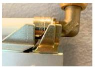
Den Dichtring auf Verschmutzung und Beschädigung kontrollieren. Für ein leichtgängiges Einstecken empfehlen wir den Dichtring vor der Montage mit Armaturenfett zu versehen.
